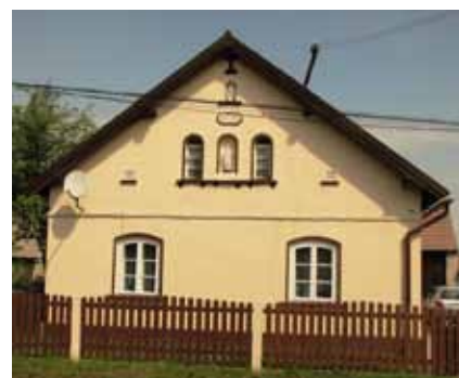
Foto 9. Żerniki - okna sklepione łukami (Rundbogenstil)
