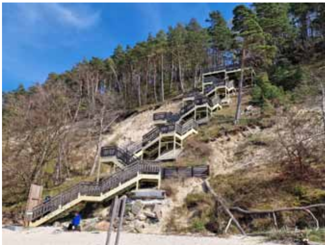
Foto 12. Schody na Kawczą Górę
