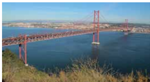
Drogowo - kolejowy most wiszący nad rzeką Tag. Łączy dzielnice Lizbony i ma długość 2277 metrów
