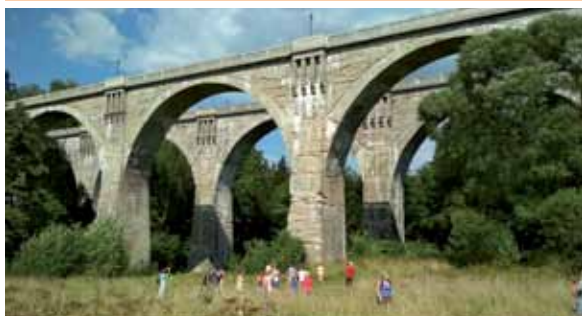
Stańczyki – Wiadukty w Puszczy Rominckiej o wysokości 36 m i długości 200 m., wybudowany w latach 1912 – 1918
