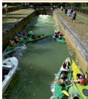
Paniewo – dwukomorowa śluza na Kanale Augustowskim. Różnica poziomów wody – 6 m. Czas śluzowania ok. 40 minut
